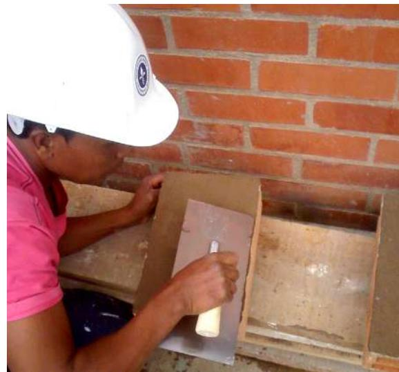
Figura 6. Revoque sobre ladrillo farol con el suelo de estudio.
