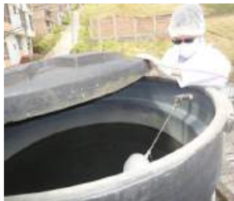
Figura 4 Tanque de asbesto
