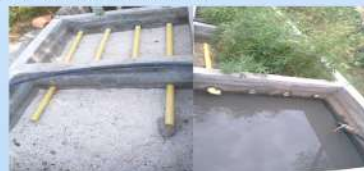
Figura 1. Construcción del humedal
