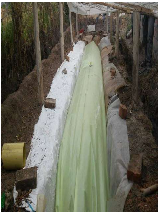
Figura 2. Montaje del biodigestor tipo tubular.
