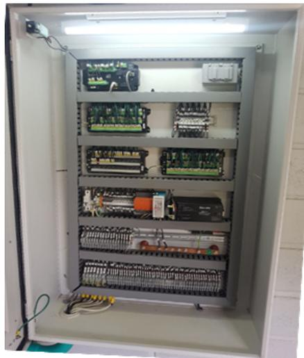
Finalmente, los sistemas integrados a este tablero se comunican con el centro de monitoreo técnico de Seguridad de Presas de EPM, formando una arquitectura de red estándar para la instrumentación geotécnica de presas de EPM (Figura 18) que permite monitorear las variables relevantes de las presas en tiempo real.
