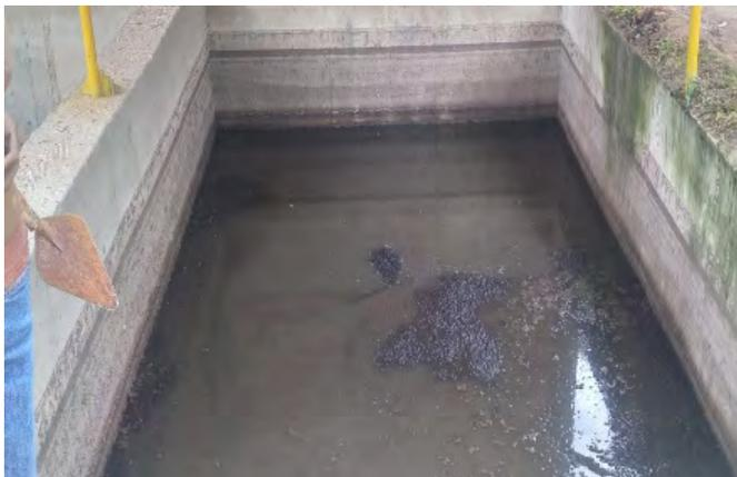
En cuanto a su estructura, sus dimensiones son: 2.10 m de ancho, 3.70 m de largo y 1,70 m de profundidad. La extracción de lodos se realiza dos veces en el año, para evitar su colmatación y dar paso a que el porcentaje de lodo tratado sea mayor.
