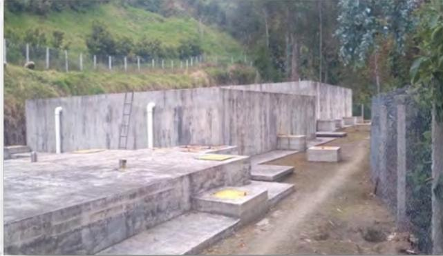
La PTAR es de tipo convencional; funciona por gravedad; recibe las AR provenientes de un alcantarillado combinado, producto del 87 % de la totalidad de aguas servidas del municipio de Gualmatán; el caudal de ingreso es de 7.6 l/s. La PTAR presenta diferentes procesos químicos, físicos y biológicos, para eliminar los contaminantes presentes en el agua efluente del uso humano (Alcaldía Municipio de Gualmatán, 2018).
